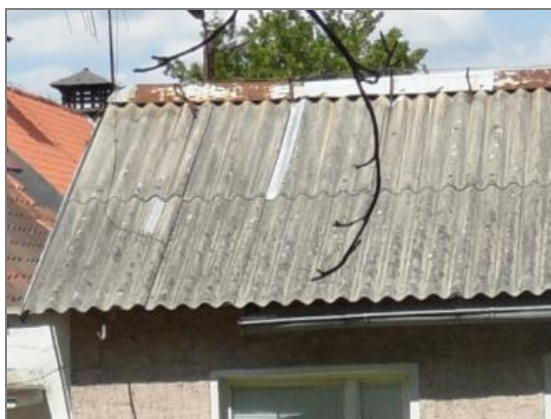
Fot. 1 Płyty azbestowo-cementowe faliste
